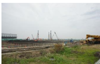
(仮称)ららぽーと富士見 着工現場
